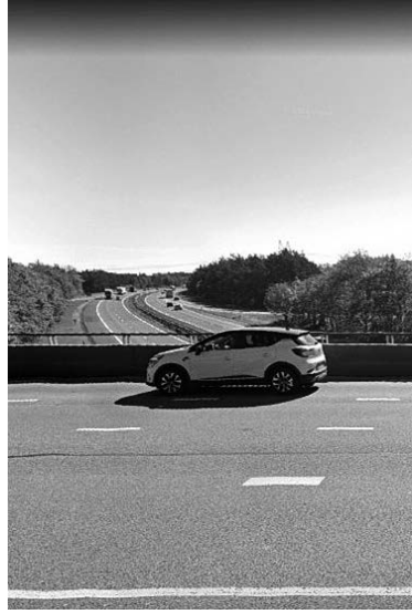
Bocht in A28 vanaf viaduct Harderwijk richting Zwolle
