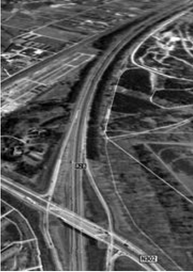
Bocht in A28 vanaf viaduct Harderwijk richting Zwolle
